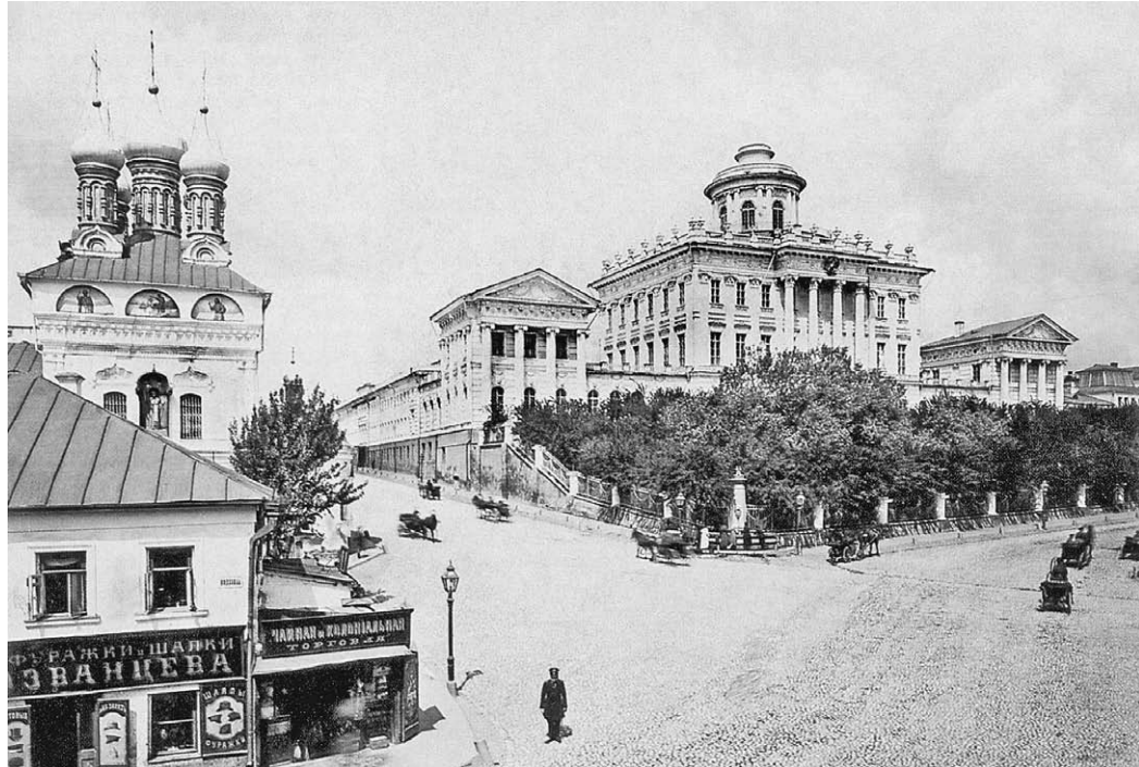
Дом П.Е. Пашкова в Москве. Главный фасад
